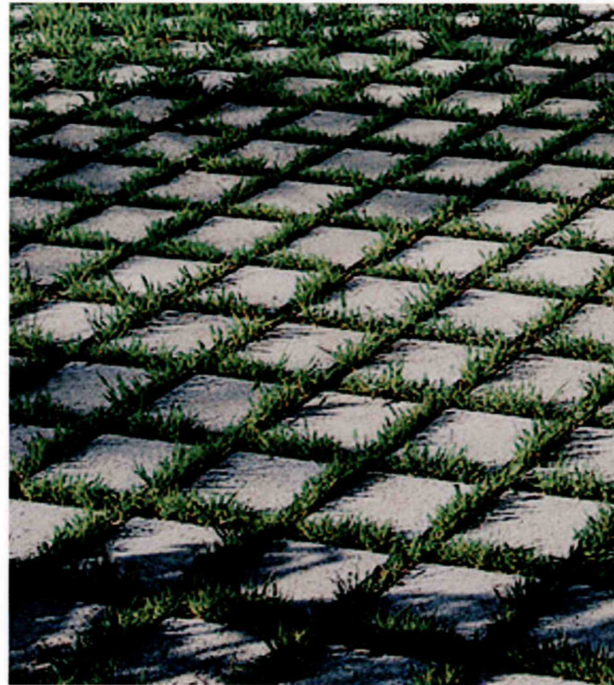
PAVAGE À JOINTS ENHERBÉS
